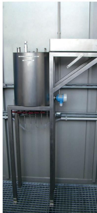
Peroxid-Vorlagebehälter mit Füllstandsüberwachung
